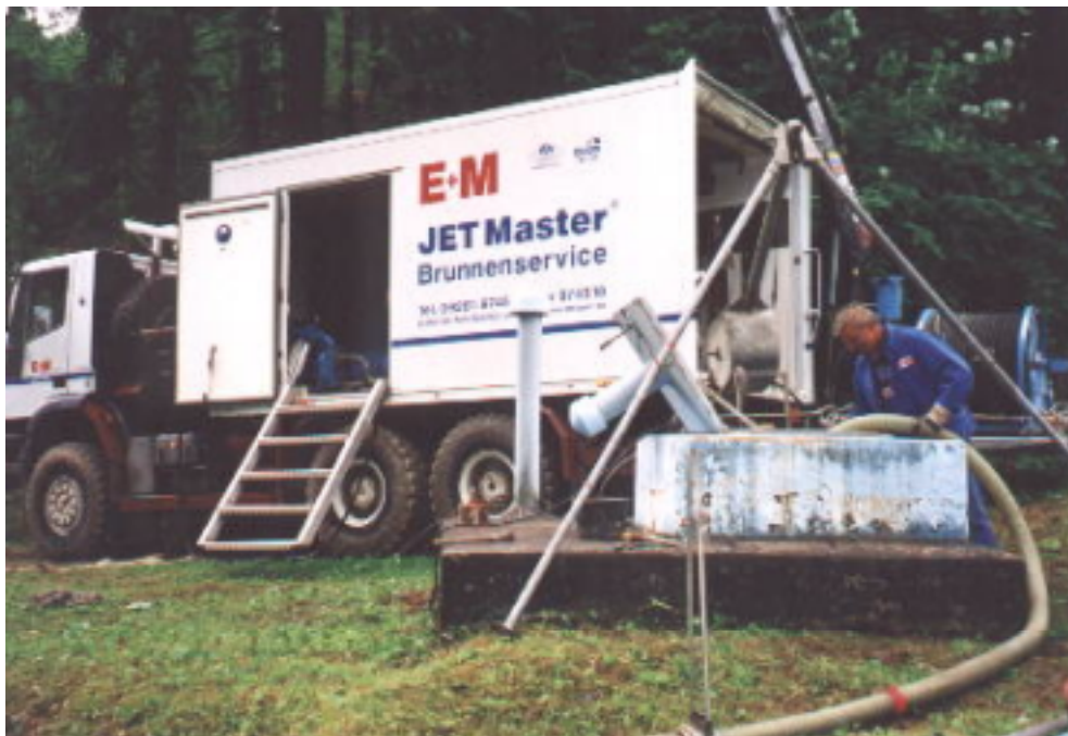
Bild 3: Baustelleneinrichtung zur Regenerierung eines Brunnens
