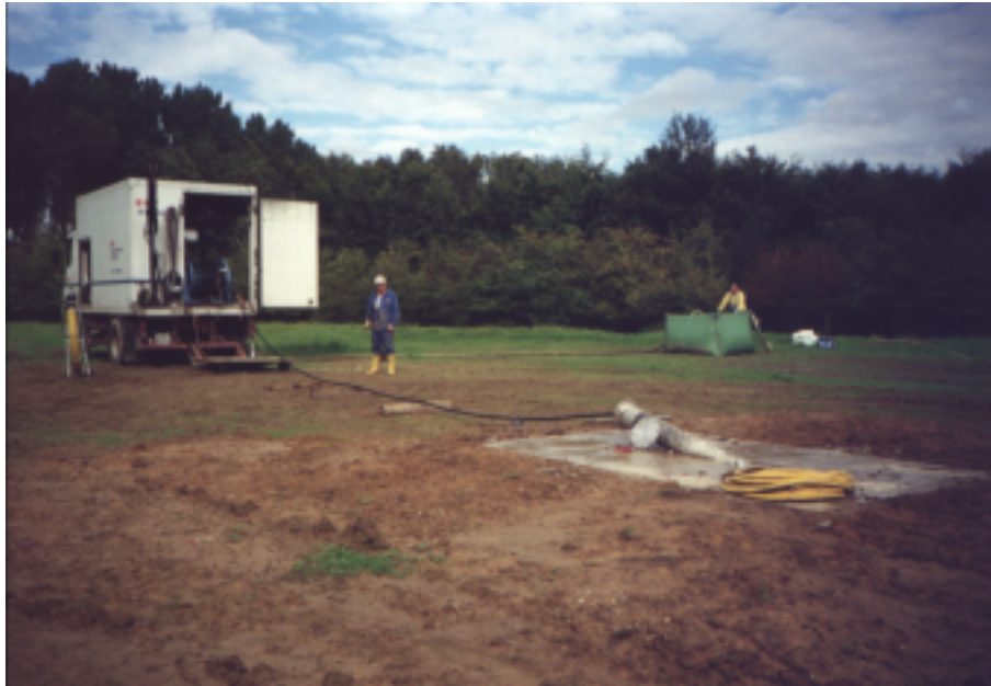
Bild 7: Einsatz des E + M JET Masters® zur Entwicklung eines Horizontalbrunnens in Krefeld
